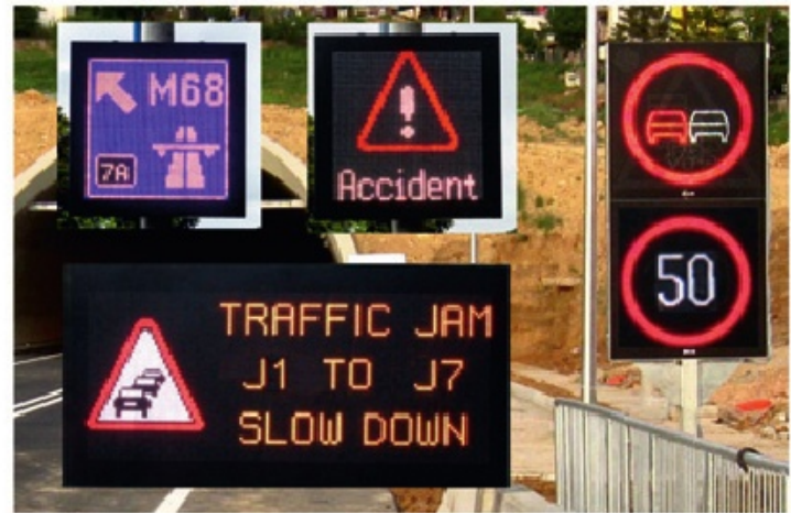
شکل ۷: نمونه ای از تابلوهای VMS
