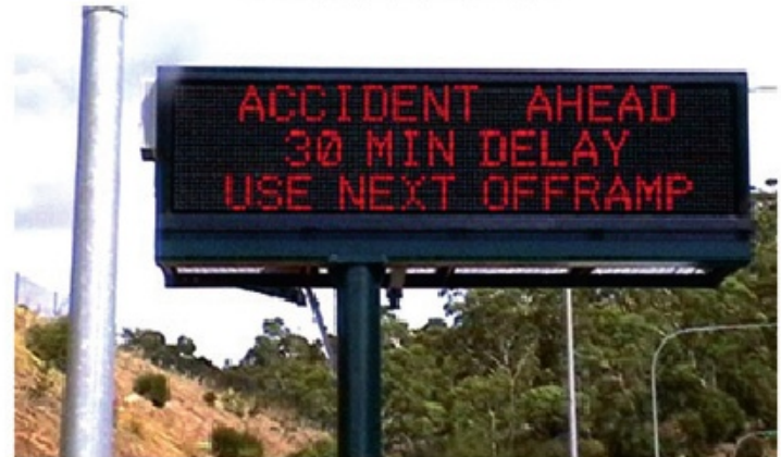
شکل ۸: نمونه ای از تابلوهای VMS
